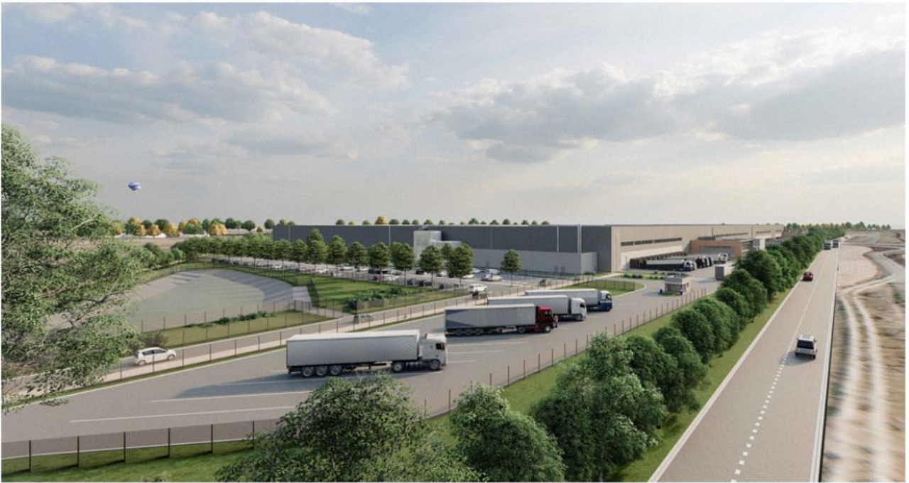
1 | Vue depuis l'entrée N°1
