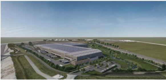
2 | Vue aeriennne depuis l'entr e N*2
